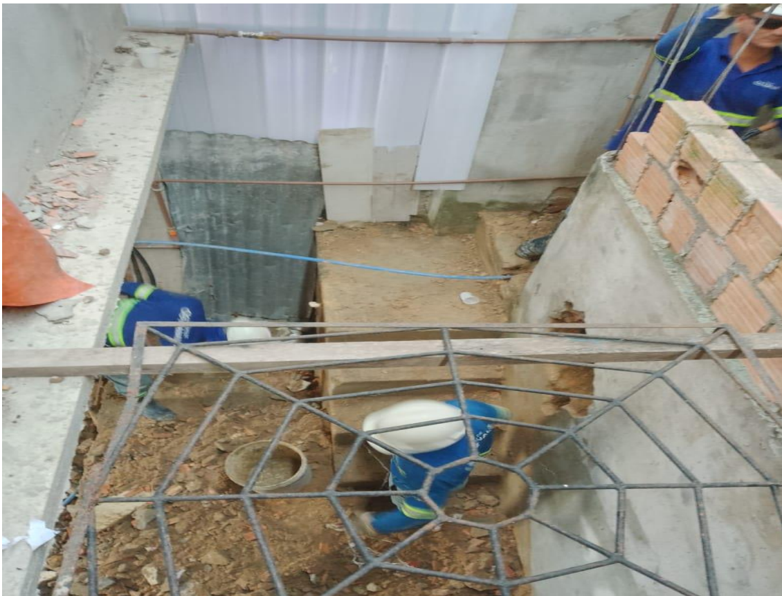
Vista da equipe técnica da Empresa Águas de Manaus realizando manutenção na tubulação.
