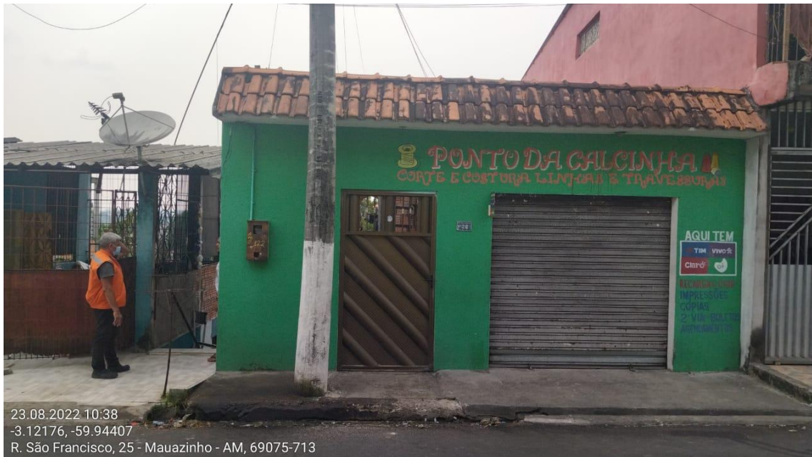
Vista dos imóveis em situação de risco.
