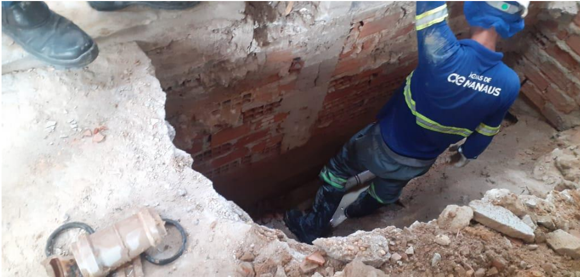
Vista da equipe técnica da Empresa Águas de Manaus realizando manutenção na tubulação.
